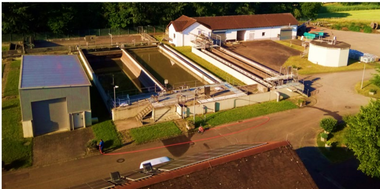
Vorklärbecken sowie Sand- und Fettfang
