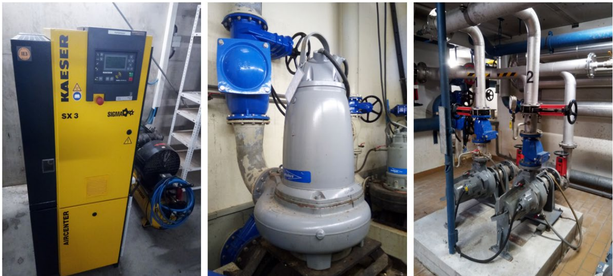
v. l. n. r.: Schraubenkompressor, Tauchmotorpumpe, Umwälzpumpe
