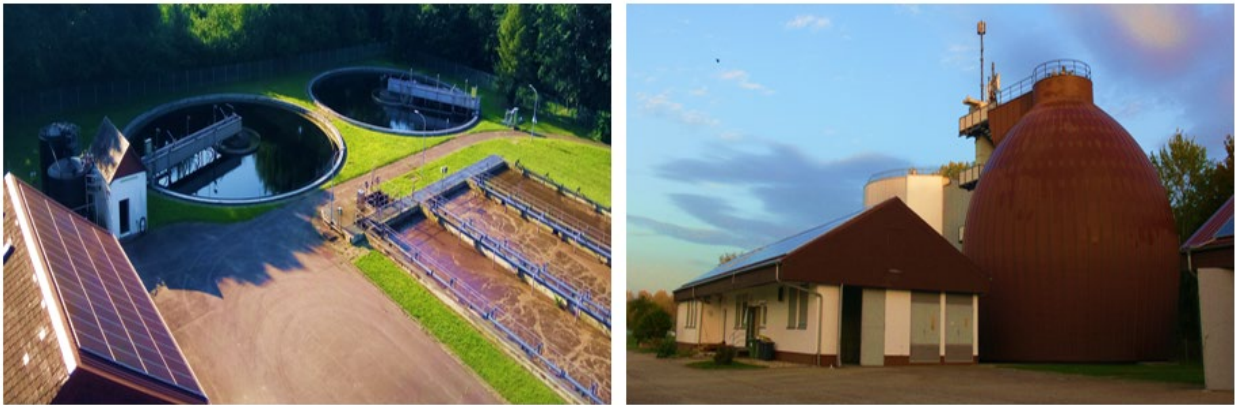
v. l. n. r.: Nachklärung und Belebungsbecken, Betriebsgebäude mit Faulturm
